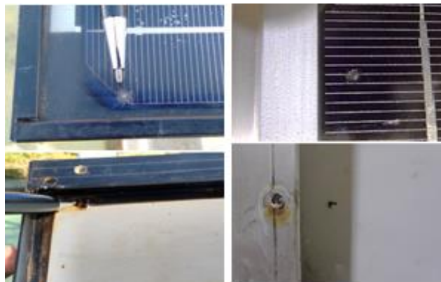
Figura 54 - Módulos danificados quando de instalação em campo
