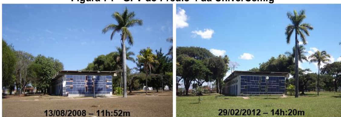
Figura 74 - GFV do Prédio 4 da UniverCemig
