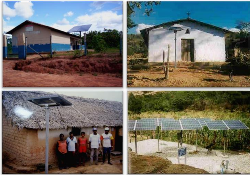
Figura 39 - Sistemas fotovoltaicos instalados em comunidades rurais
