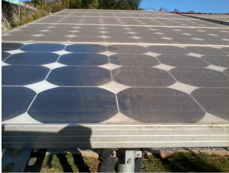
Figura 81 - Camada de poeira depositada sobre módulos do GFV
